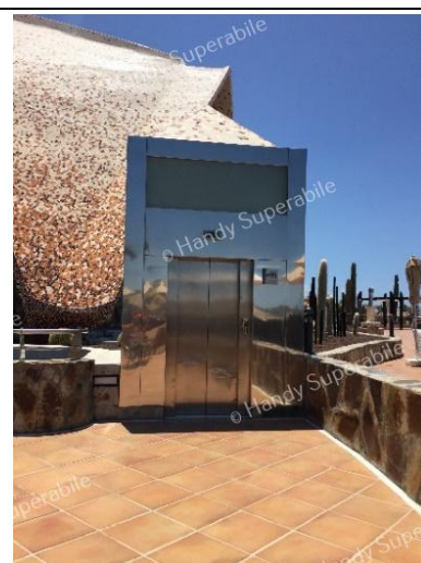
Ascensore blocco C
